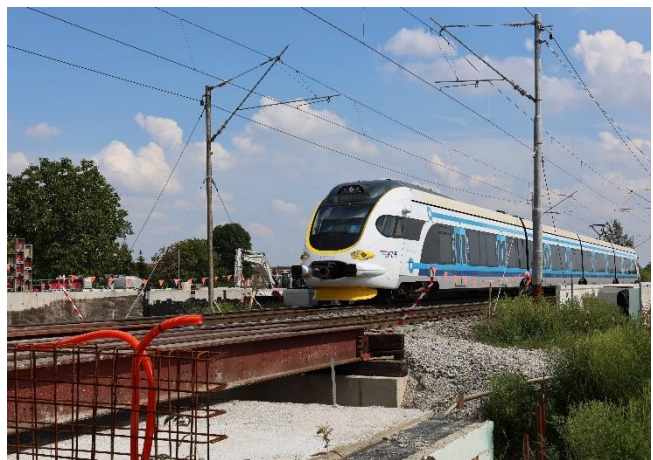
Slika 5. Željeznička postaja Sesvetska Sela – u izgradnji
